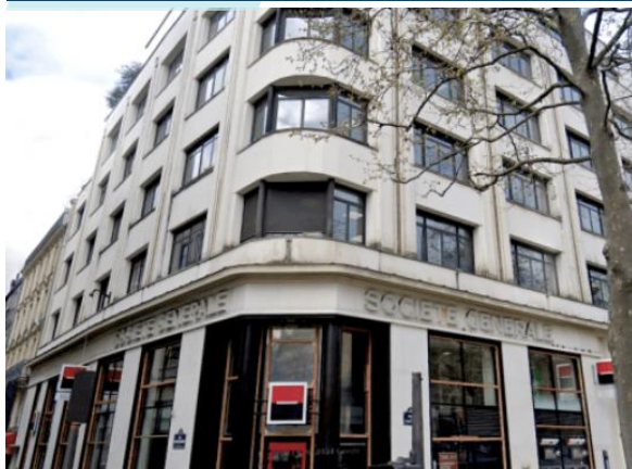
Immeuble mixte / PARIS 08 (75) 29/33 Avenue des Champs Elysées
