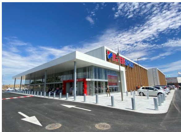
SLB Intersport (02) 1 bâtiment commercial
